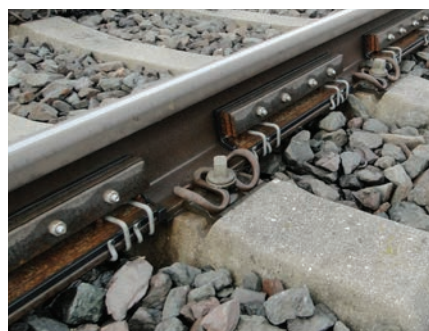
Dostrojone absorbery zamontowane w torze z podsypką
