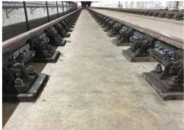
*Angepasste Schienenstegdämpfer an einer UIC-60-Schiene, Feste Fahrbahn*
