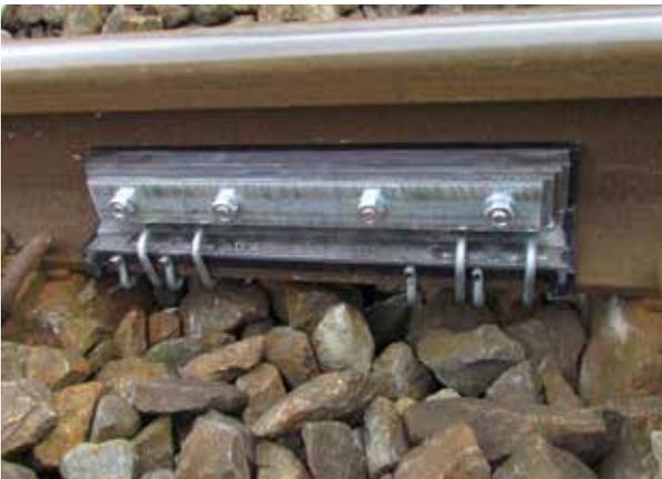
*Angepasster Schienenstegdämpfer an einer UIC-54-Schiene, Schottergleis*
