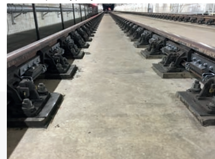
Dostrojone absorbery zamontowane w torze bezpodсыpkowym
