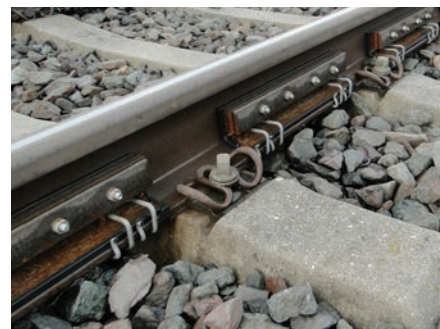
Dostrojone absorbery zamontowane w torze z podsypką
