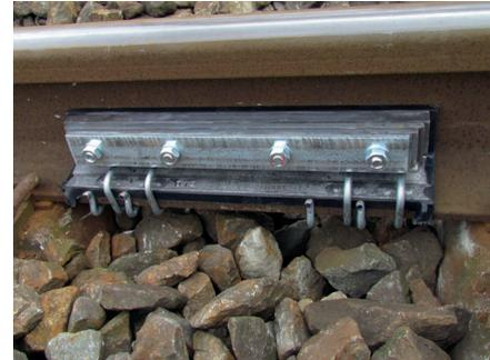
Angepasste Dämpfer an einer UIC-60-Schiene, Schottergleis
