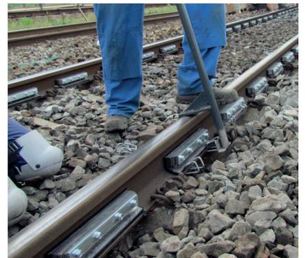
Die Montage pro Gleis sollte mit einer Personalstärke von 18 Personen erfolgen. In dieser Konstellation ist eine Montagegeschwindigkeit von 300 Metern pro Stunde möglich.
