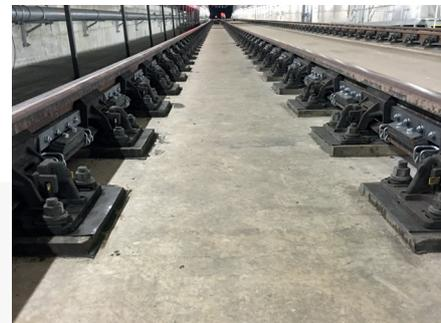
Angepasste Dämpfer an einer UIC-60-Schiene, feste Fahrbahn
