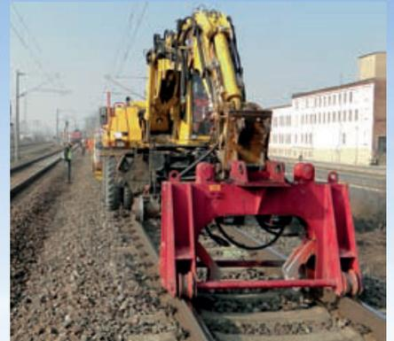
Gleichzeitig erfolgt die Materialversorgung über eine Transporteinheit, die vom Bagger gezogen wird. Somit kann unmittelbar nach Einsatz des Zweivegebaggers mit der Montage begonnen werden.
